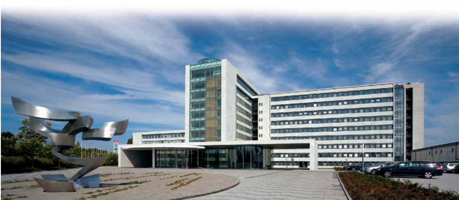
Danfoss A/S Genel Merkez Binası Nordborg / Danimarka
